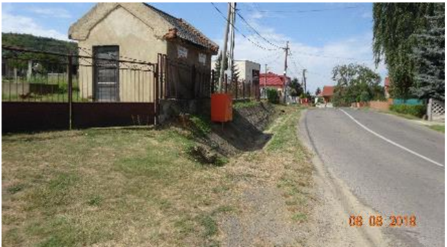
OBR. 4 - KONIEC RIEŠENÉHO ÚSEKU PRI CINTORÍNE
